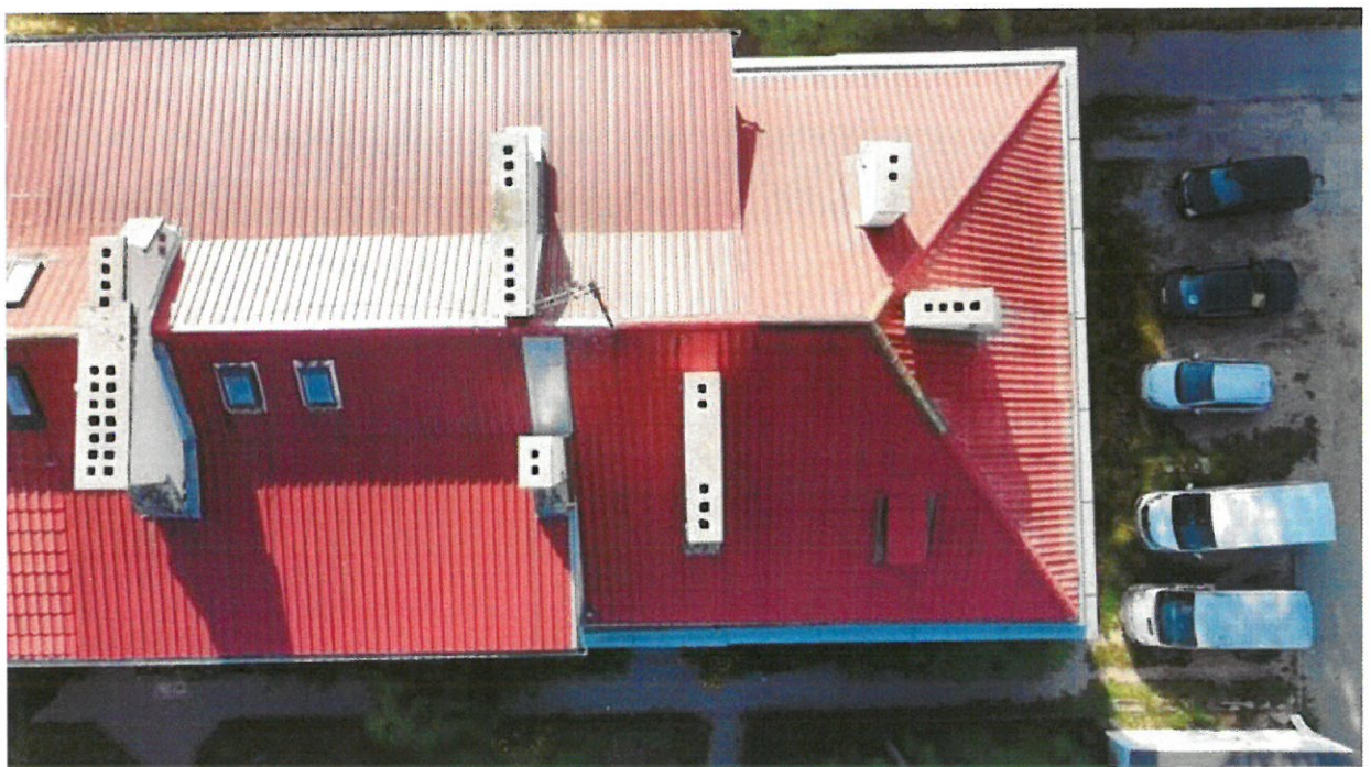
Pokrycie nad lokalem nr 19 i poddaszem (widok z góry)
