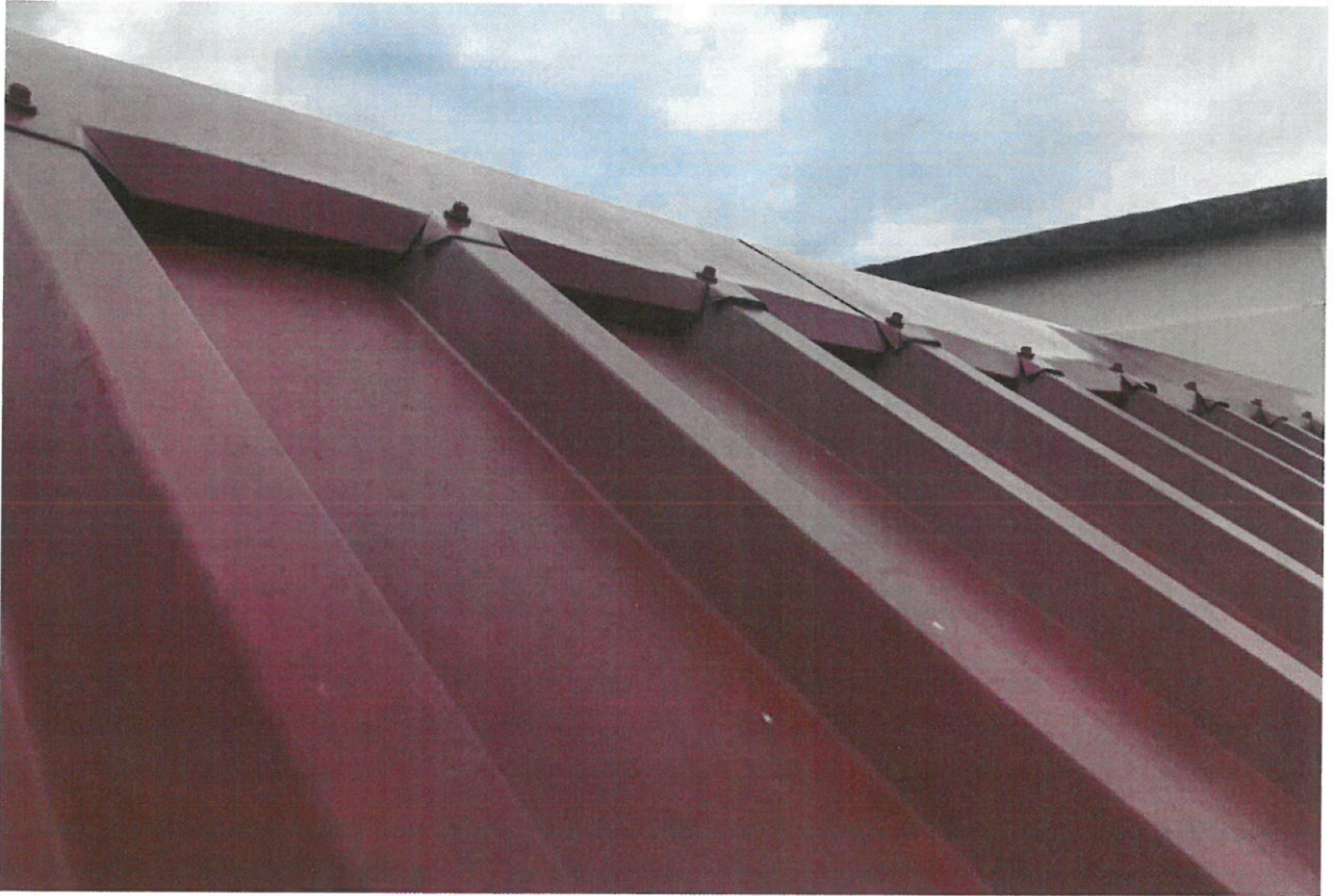
Pokrycie nad lokalem nr 19
