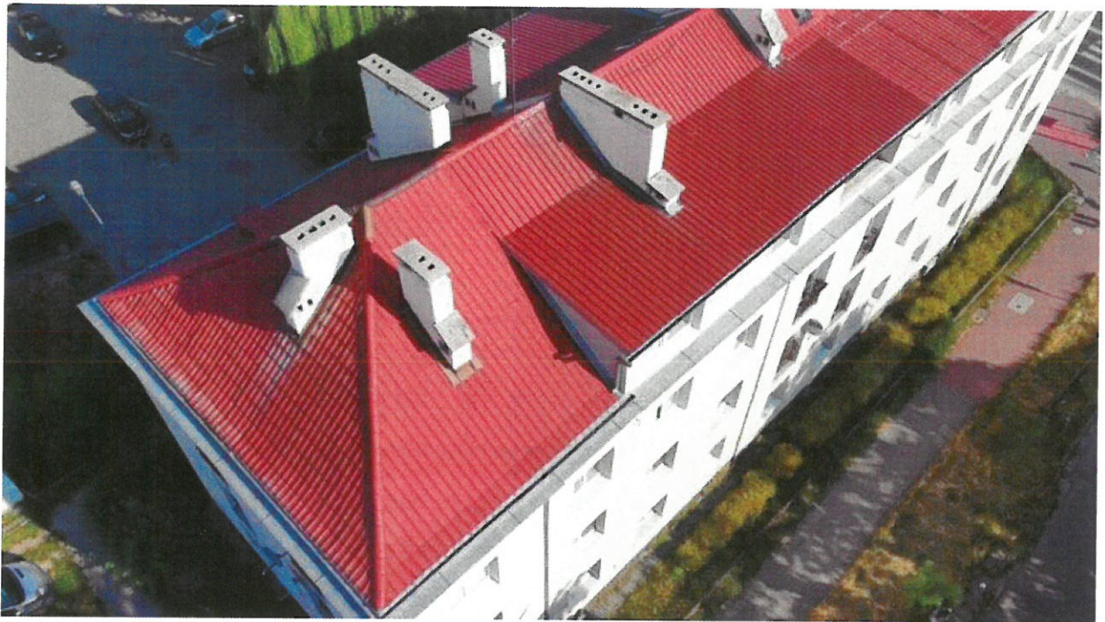
Pokrycie nad lokalem nr 19 i poddaszem (widok z góry od ulicy Obr. Westerplatte)
