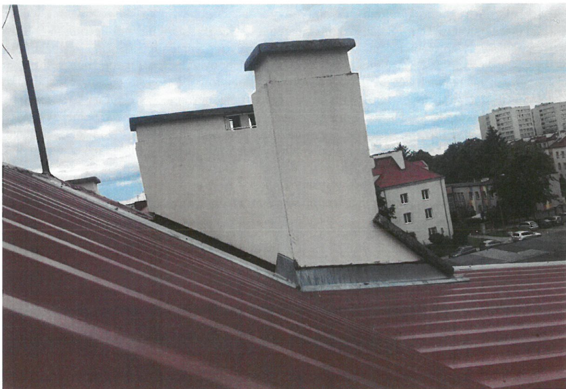
Komin nr 4 (z przodu) i komin nr 3 (za kominem nr 4) oraz pokrycie nad lokalem nr 19
